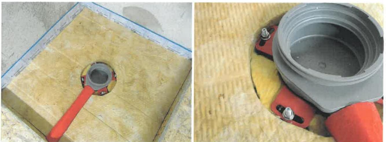
Oben links: Stockschrauben in "Setzungsdämpfer" befestigt.
