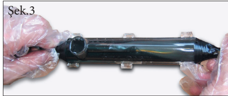
Şek. 3: Korumayı önceden hazırlanan döküm reçinesi ile kalıplayın
