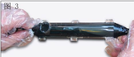
图 3: 用准备好的浇铸树脂浇铸外壳
