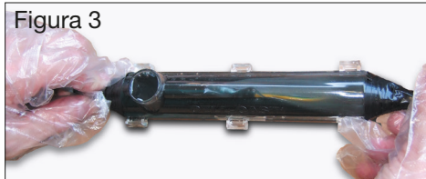
Figura 3: riempire l'involucro con resina da colata
