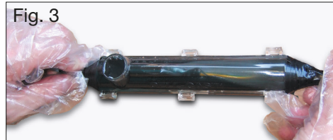
Fig. 3. Obturez la coque avec la résine de coulage préparée
