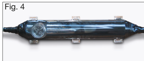
Fig. 4. État final avec le bouchon de fermeture
