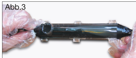
Abb. 3: Schale mit vorbereitetem Gießharz ausgießen
