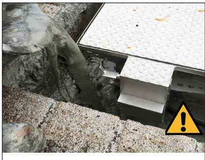
DE: Einfassung ausbetonieren, dabei statische Anforderung der beiliegenden OEM-Anleitung beachten. Für Lastklasse D ist entweder eine Lastverteilplatte oder ein tragender Straßenaufbau erforderlich. Der Deckel muss in voller Rahmenhöhe mit Betongüte C35/C45 einbetoniert werden. In jedem Falle ist die Betongüte zu beachten und eine Rüttelmaschine für die ordnungsgemäße Unterfütterung zu verwenden.
