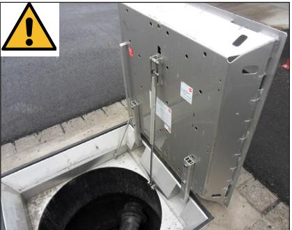
DE: Zur Sicherheit während des Einstiegs Deckel in senkrechter Position arretieren. Endmontage gemäß OEM-Anleitung ausführen.
