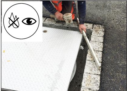
DE: Abdeckung zusammen mit Aufsatzstück einschieben, dann auf gewünschte Höhe ausnivellieren.
