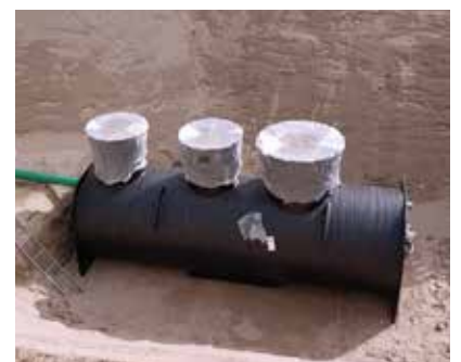
Fettabscheider EasyClean ground Auto Mix & Pump NS 10 mit Hebeanlage Aqualift F XL
